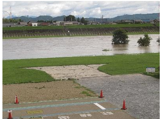
(上流の大雨で増水した南派川)
